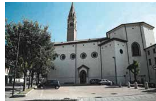
Chiesa di Laghi - lato ovest
