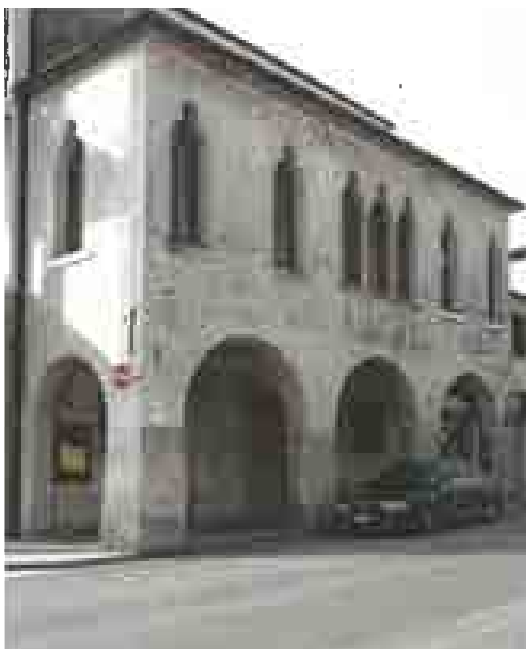
Palazzo Podesteria di Dentro facciata est
